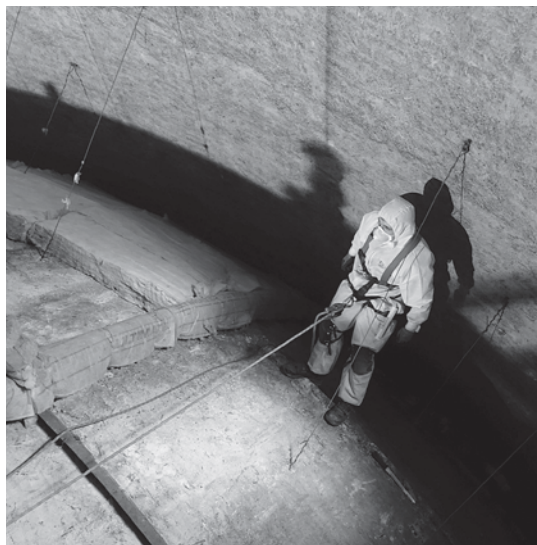
Schwieriger Arbeitsplatz im Dachraum.
